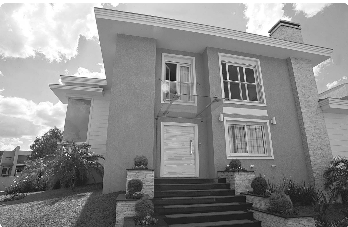
Detalhes de friso e apliques em madeira na porta feita sob medida pelo escritório Lupatini, Lima, Ramos.
