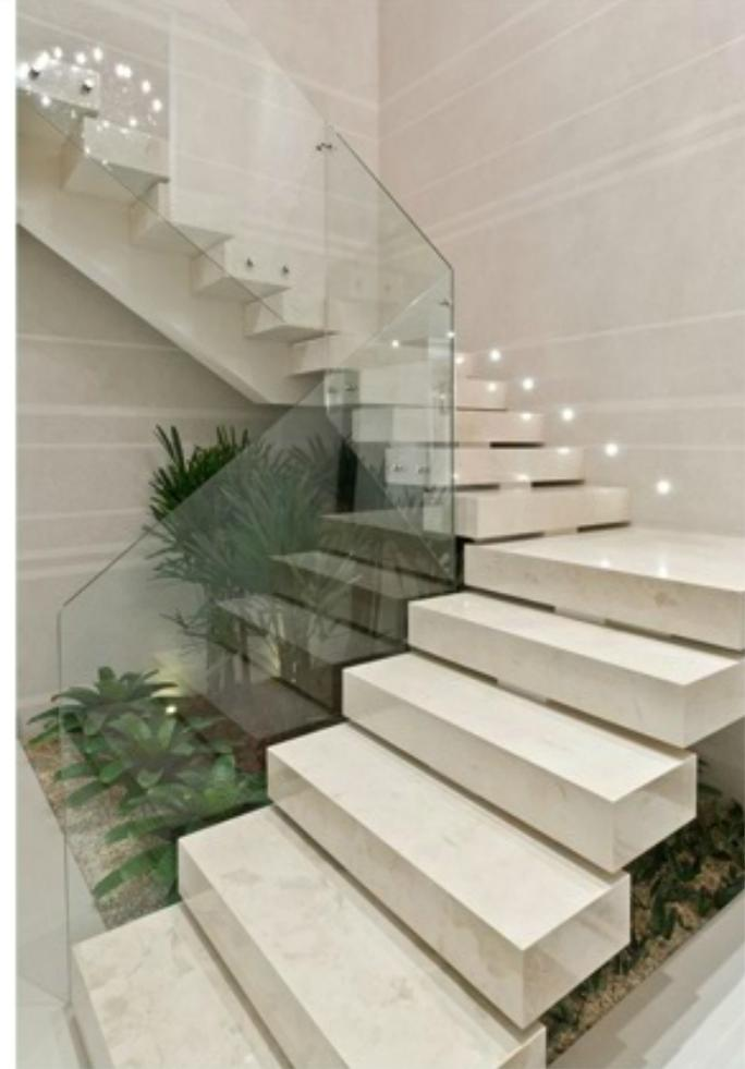
A parede da escada recebeu uma técnica feita com a mistura de pó de quartzo de três cores diferentes, com massa acrílica pigmentada da cor da parede, em listras horizontais de diferentes alturas, para quebrar um pouco da verticalidade da parede. O trabalho foi concebido pela artista plástica Marilene Ropelato.
